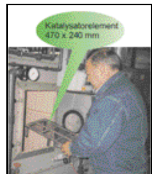
Installation eines MOL®CLEAN-Katalysatorelementes vom Typ F1.8S in einen Umlaufsprühbefeuchter
